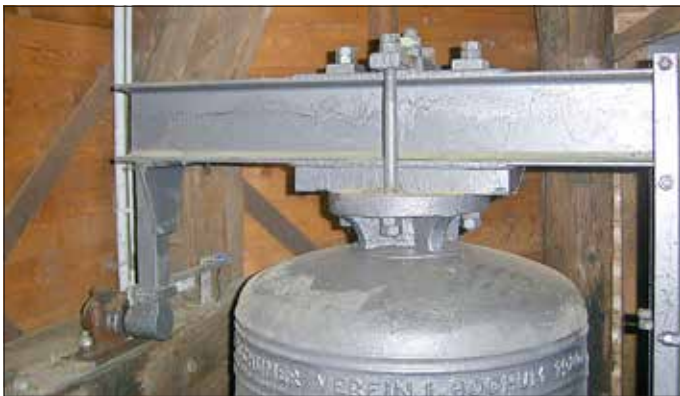
Stahljoch der mittleren Glocke (Zimmermann)
