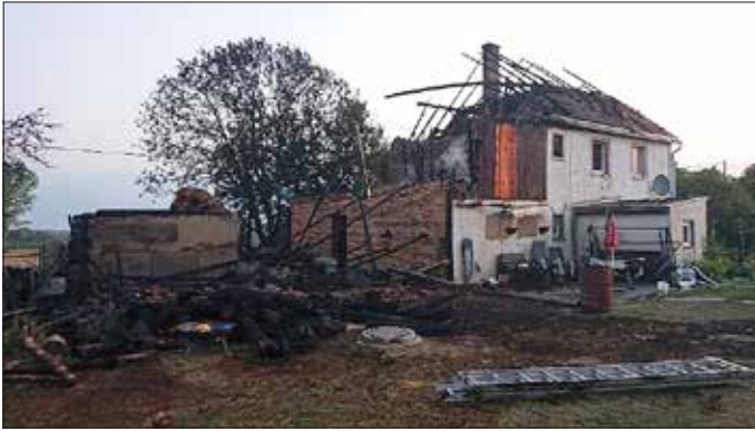
13.08.2020 – Wohnhausbrand in Krummenhennersdorf
